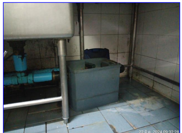
รูปที่ 2.2 ถังดักไขมันใต้อ่างล้างจาน
