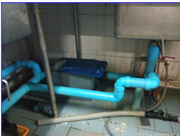
รูปที่ 2.2 ถังดักไขมันใต้อ่างล้างจาน
